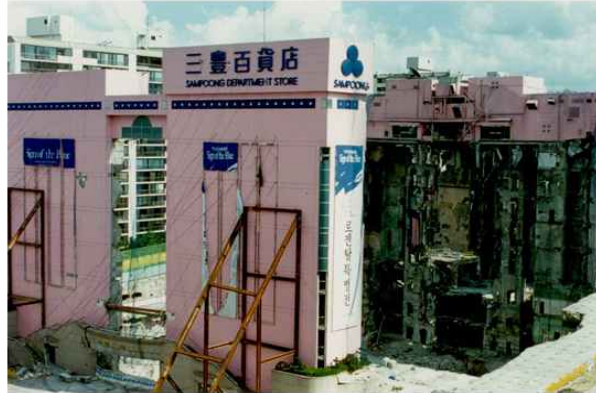
잔해 제거 후 현장 전경
